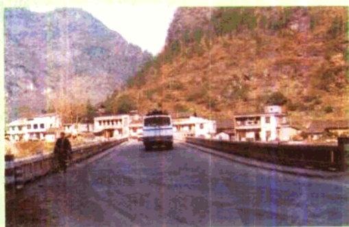
易家坝公路桥
