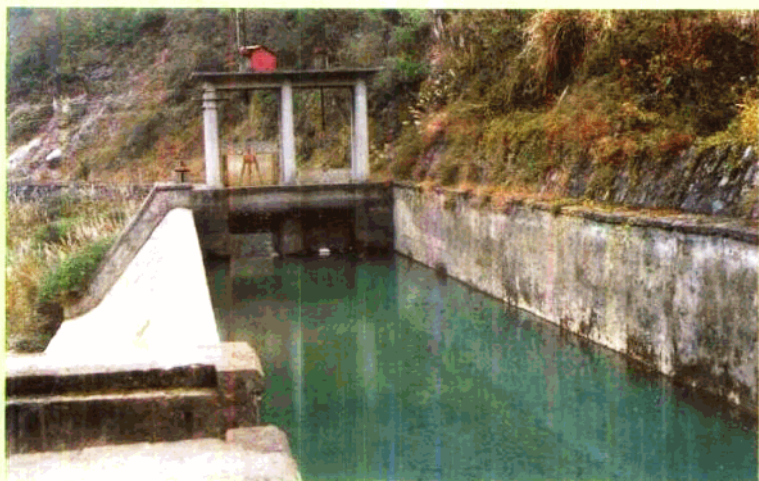
引水、泄洪设施
