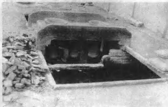
普陀山沼氣池
