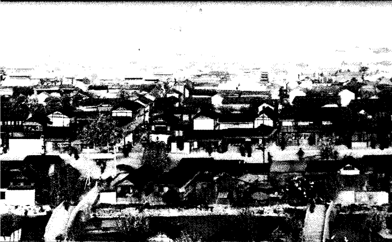
临安棚桥书市
