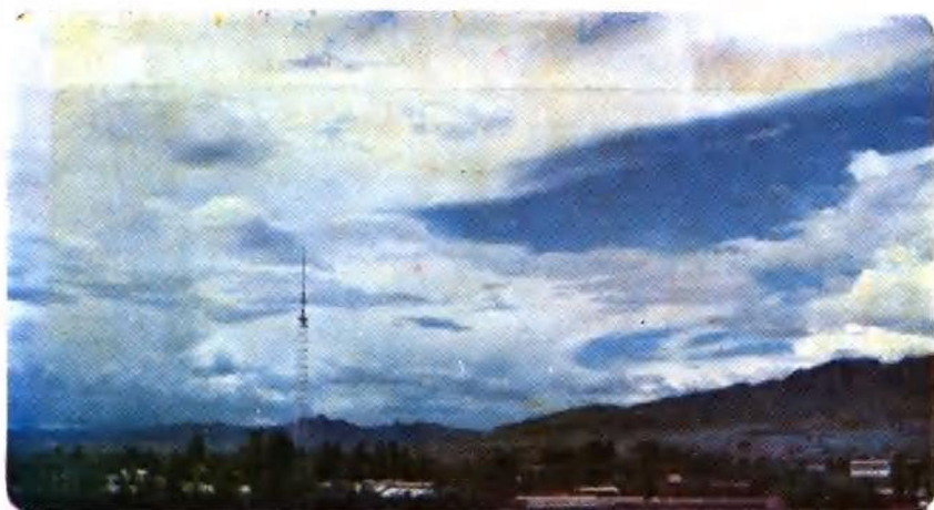
电视台发射塔
