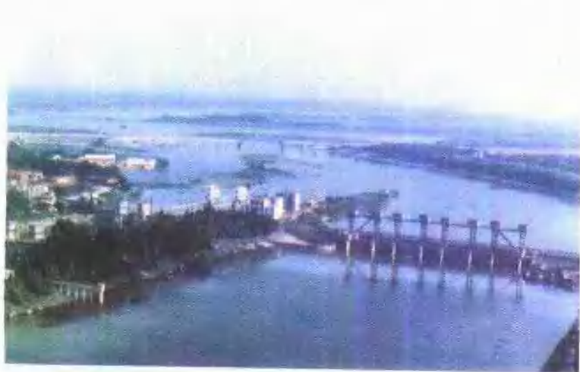
汉北河排洪工程
