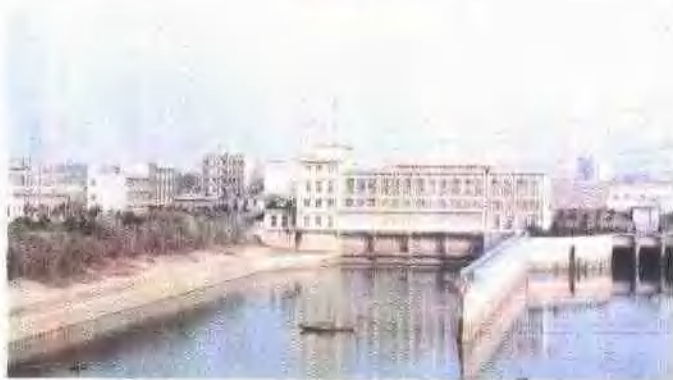
汉川泵站二泵站
