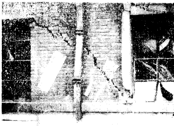
图1-13 墙体斜裂缝
