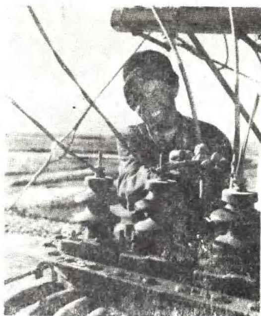
水电站工人在检修线路
