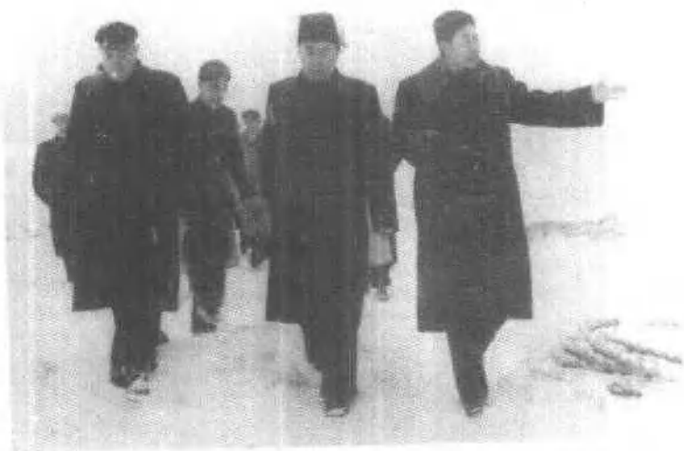
1958年2月底，周恩来同志冒雪视察荆江大堤，林一山同志（右一）陪同汇报
