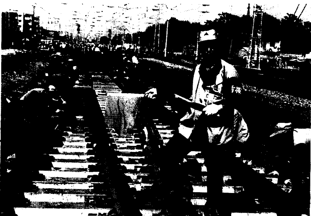
▲ 漯河工务段更换提速道岔 (曙光 摄)
