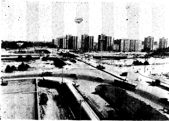
图 1-2 北京三元立体交叉桥
