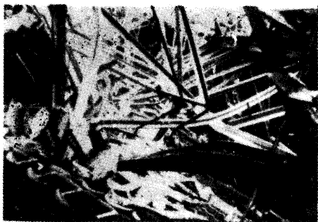
图2 坠毁后的哈特福特城体育馆网架结构
