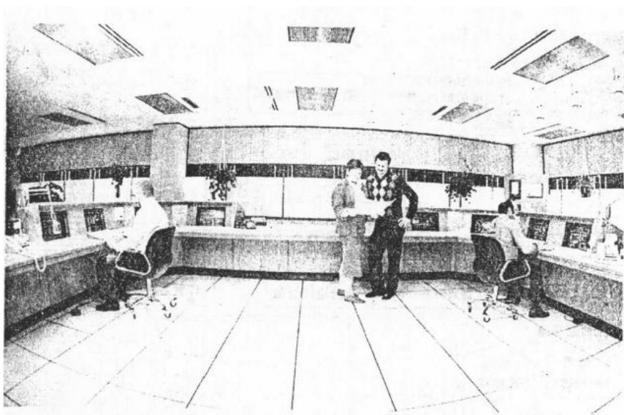
照片 1-1 天然气管网控制中心
