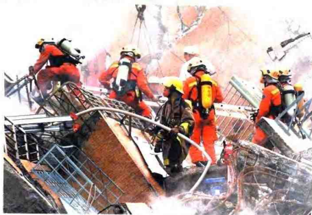
消防人员日夜不眠地在东星大楼瓦砾堆中抢救受难者。
