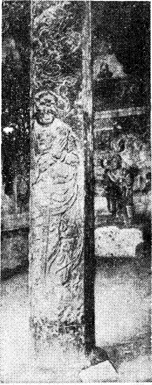
初祖庵大殿 浮雕彩绘石柱
