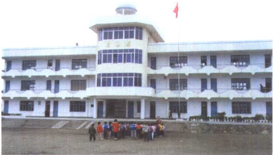
县政协曾对山区教育组织过多次视察，提出过许多建议。在党和政府领导下，山区教育楼实现旧貌换新颜。图为安地镇小学全景。
