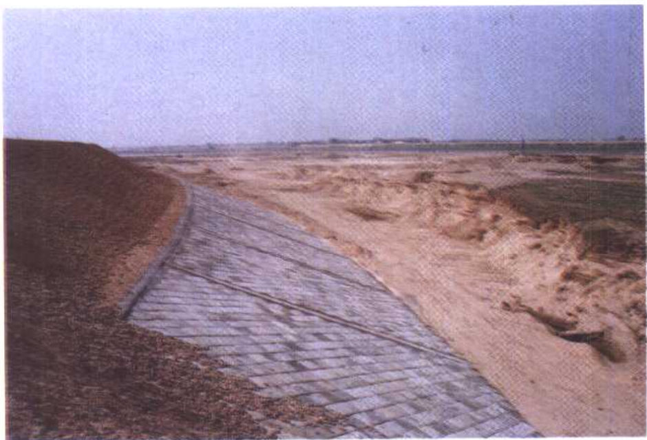
政协委员关心“三江”治理，提出提案，建议修建洋埠至罗埠的衢江防洪大堤。现已竣工，被刘锡荣副省长称为“浙西第一堤”。
