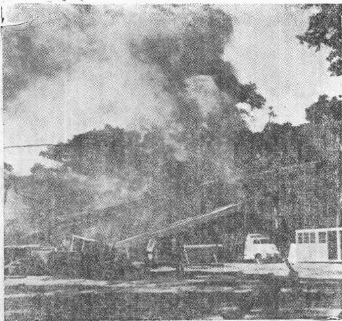
图1-5 钻铤使井架歪歪斜斜，照片表示井架正在倾倒， 但钻机尚未着火
