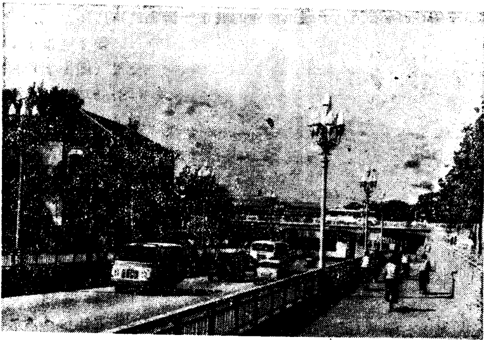
图1-7 河北省石家庄市解放路分离式立体交叉（地道桥）
