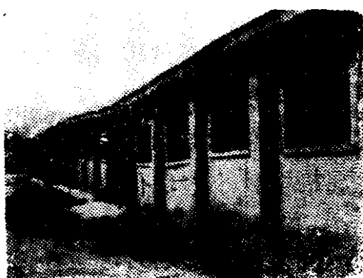
照片 1—1 因下沉建筑物呈波浪形
