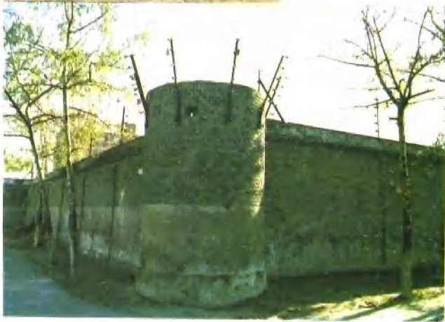
⑥ 炮局现存的炮楼残部照片
