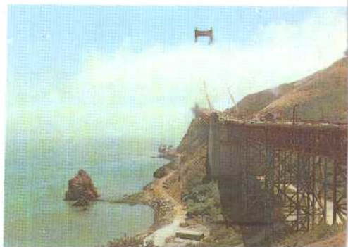
浓雾笼罩中、气势雄伟的旧金山金门大桥 周慈朴 摄
