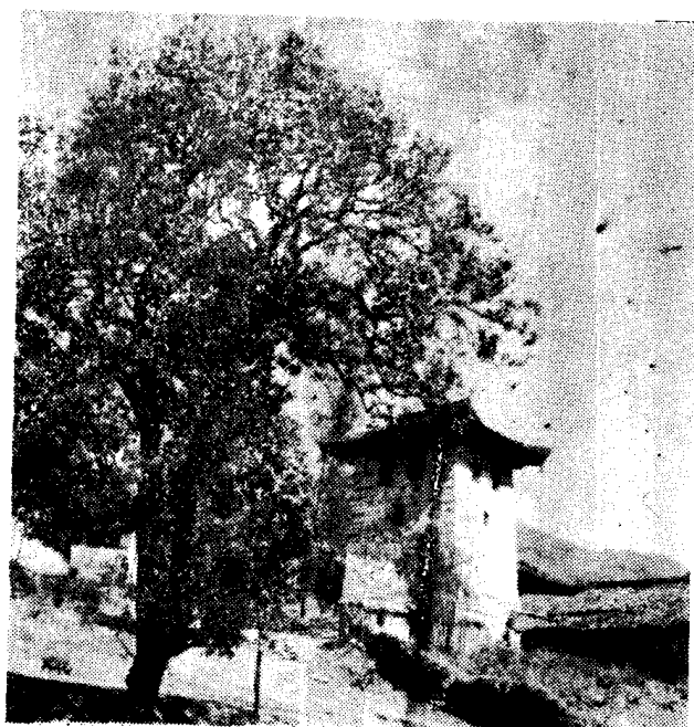
甘洛一土司衙门的五层石砌碉楼
