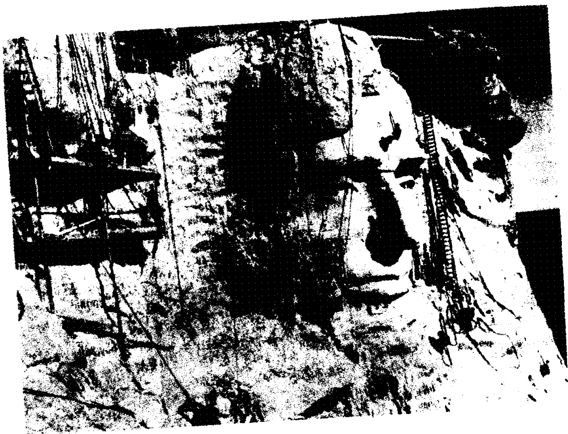
图 1-1 卢西摩尔山中的罗斯福及林肯雕像 G. 博格勒姆 (Borglum) 选择了这个位置, 并仔细地调整了雕像的方位以适应岩体的缺陷。风化的岩石用控制爆破炸掉, 孔距和装药量随着临近最后表面而逐渐减小, 最后几英寸是用密集的钻孔和凿子削去的 [查利斯·德默莱 (Charles d'Emery) 摄影。经 L. 博格勒姆 (Borglum) 和 K. C. 登·都文 (Den Dooven) 同意复制。录自《卢西摩尔山风光的故事》, K.C. 出版社, 1978]
