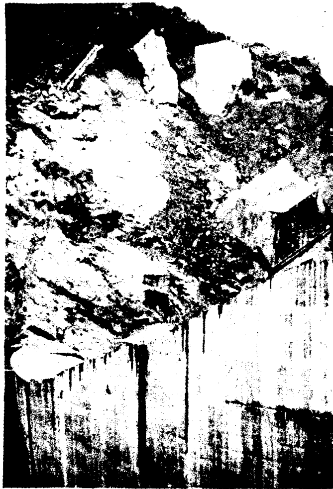
图 1-5 马尔巴赛拱坝失事后左坝头一瞥 不连续面切割成的楔形体的移动导致混凝土拱的破坏，其中一个不连续面形成坝头新露出的岩面
