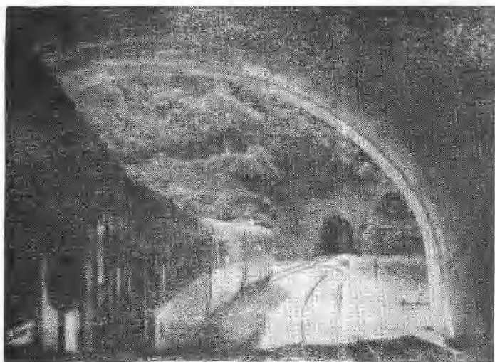
照片五 贝巴铁路穿过隧道
