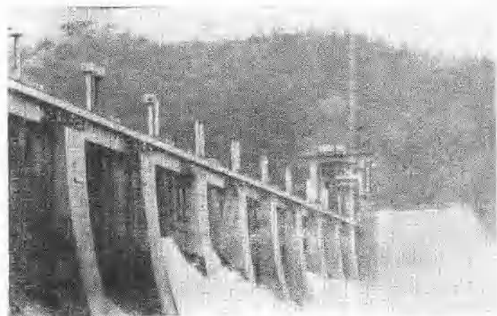
照片二 铁门水电站大坝
