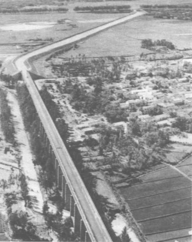
雷州青年运河大渡槽
