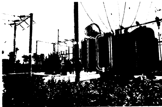
四川灌县有小水电站近百座,并建设了三座变电站,架设或改善输电线路约1,000公里,形成了当地的电网系统。这是灌县新建的中心变电站
