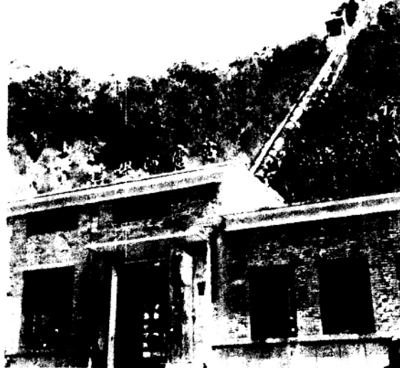
档坝河电站机房一角
