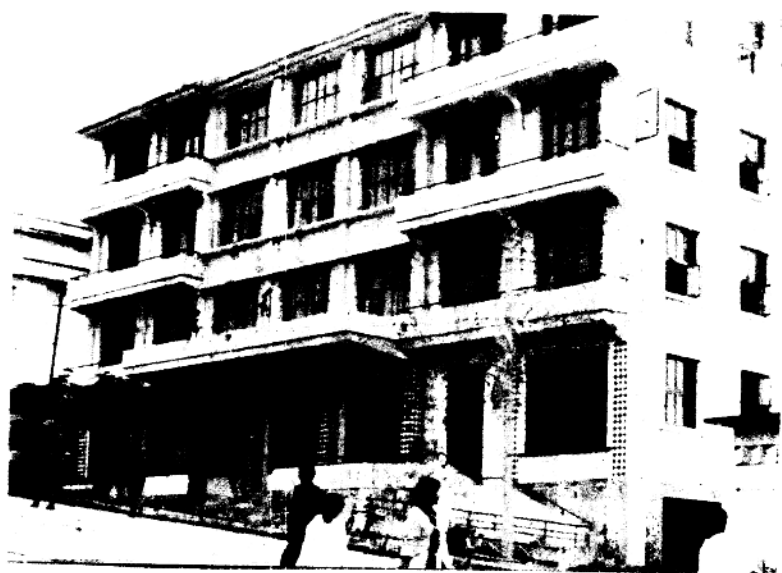
新建的电力公司大楼
