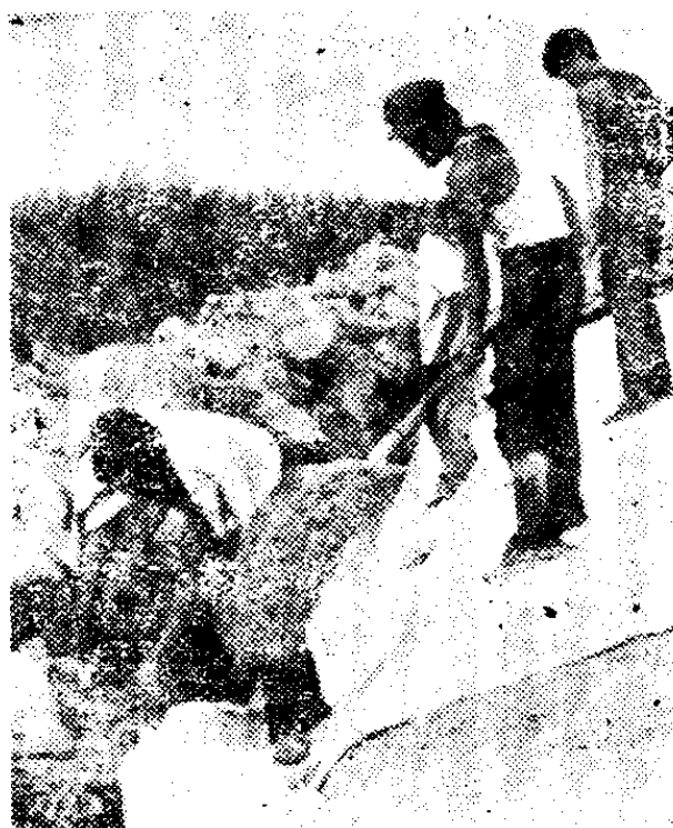
图7 土工布在路基上铺设时情况
