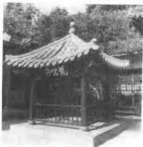
一九八六年五月修復後之平武縣報恩寺內明代范公升亭
