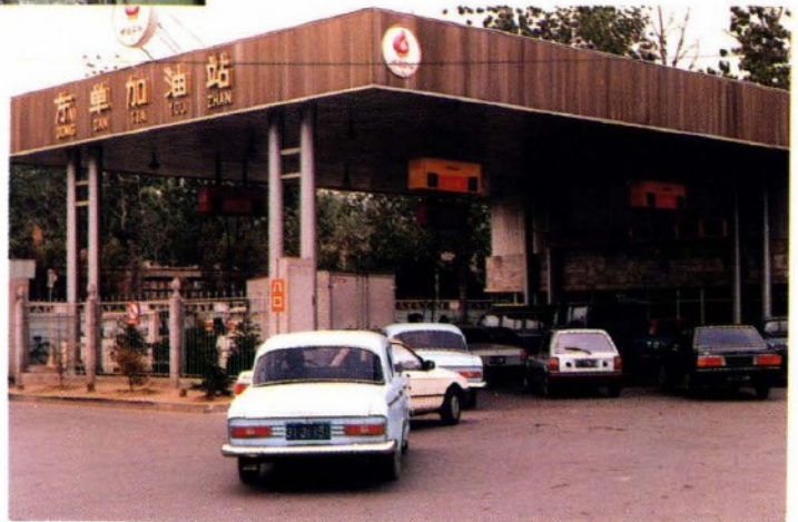
右：我市第一座现代化加油站——东单加油站。
