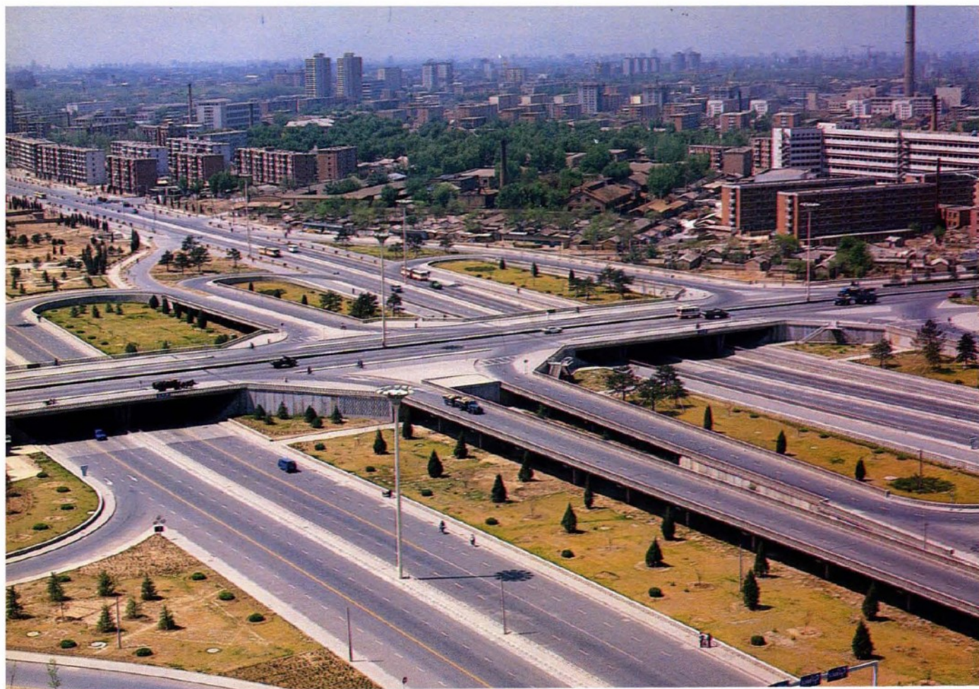
上：我国目前最大的道路立交桥——三元桥，由三座钢筋混凝土立交桥，五座栈桥，八座地下人行通道，十条匝道等组成，其占地35公顷。
