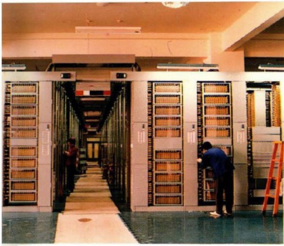
上：东单电话局装机容量一万门的纵横制自动电话交换机。
