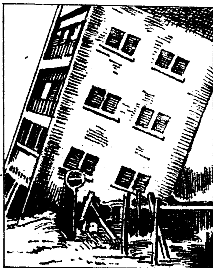
图 1-8 土液化造成的震害
