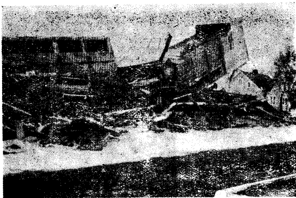
图 1-2 四季公寓倒塌情况[6]
