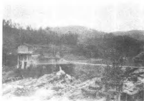
1958年冬建成发电的龙山第一座水电站——跳鱼洞电站
