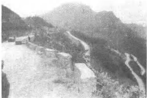
1958年2月通车的永龙公路龙山沙子坡段
