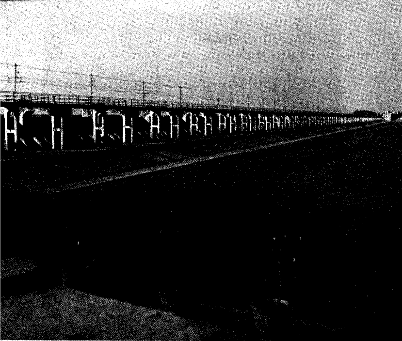
荆江分洪工程进洪闸(北闸)
