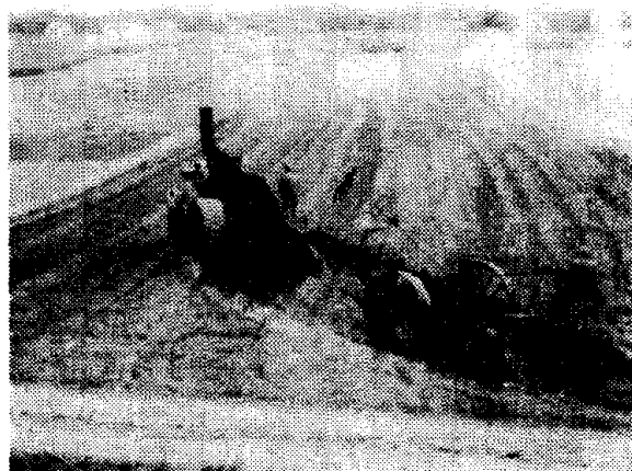
图4 在1982年的一次表演中,一台20世纪初制造的蒸汽犁正牵引着一台重5t的翘板式双向犁驶向作业地点,它是现在保存在圣伯龙的两台已修复了的蒸汽犁中的一台
