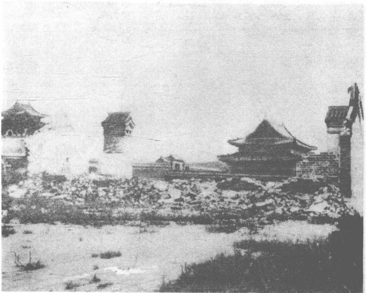
同 治 陵 外 殿 被 毀 之 一 部
