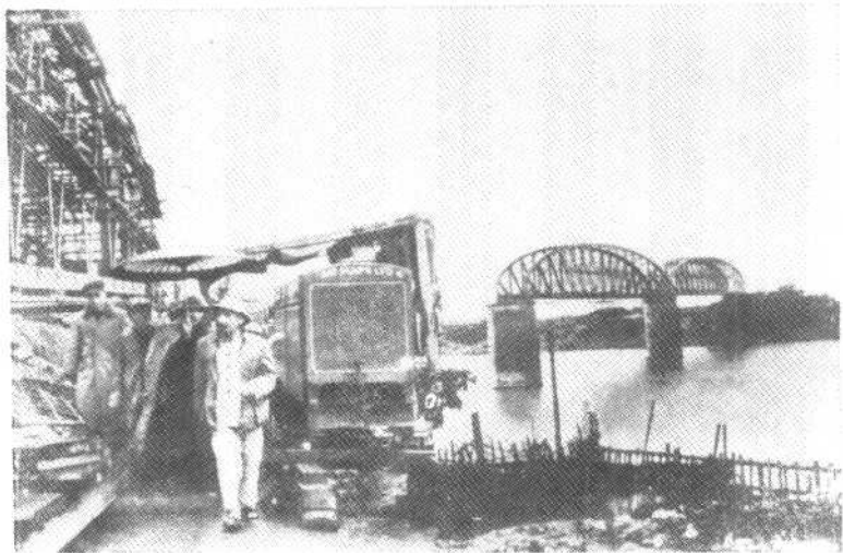
胡志明视察中国援建的越池大桥工程
