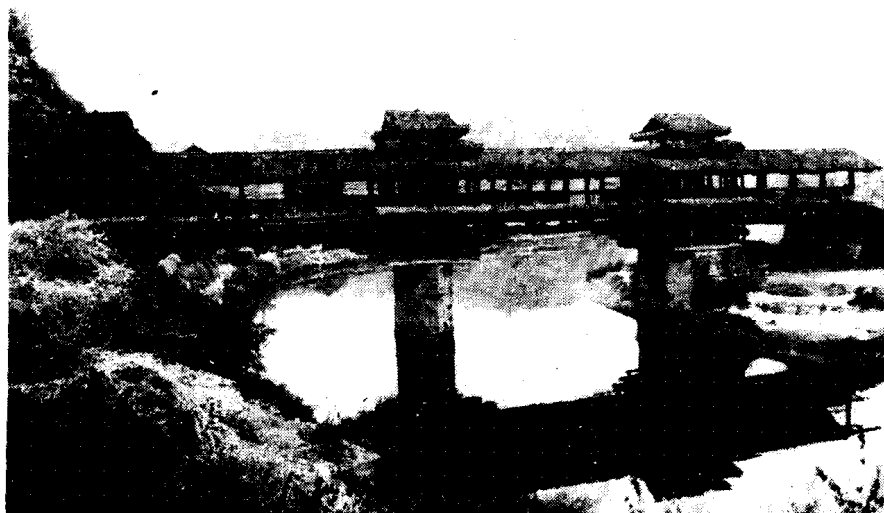
图 2 桂北平岩寨风雨桥
