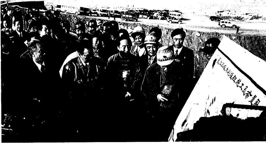
3. 1995年11月8日，李鹏总理和邹家华副总理等领导视察三峡工程工地并现场办公 (三峡开发总公司 供稿)
