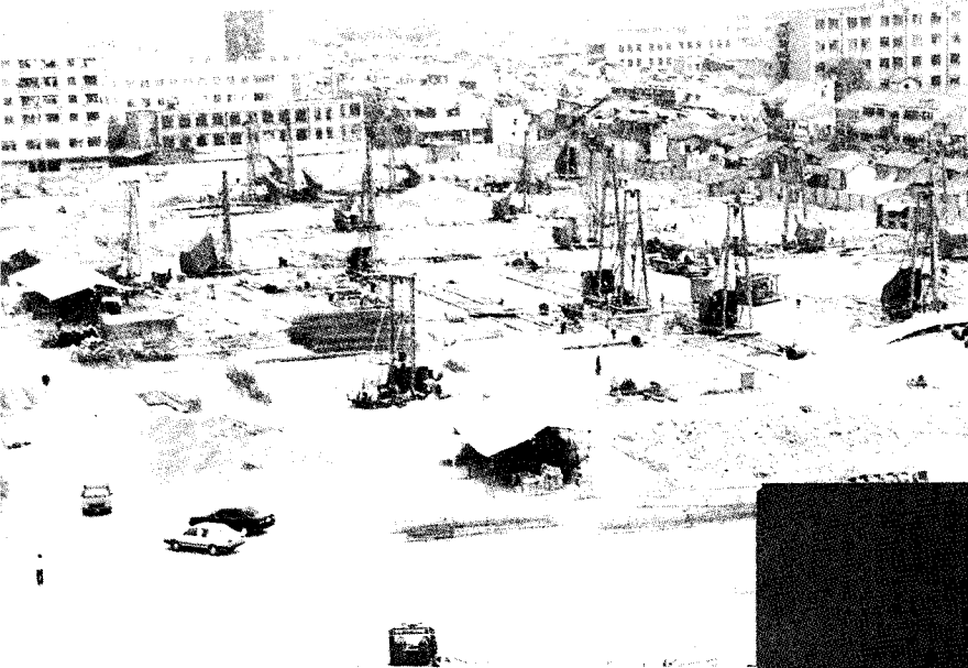
中国地质工程公司上海 公司施工的上海港汇中心桩 基现场
