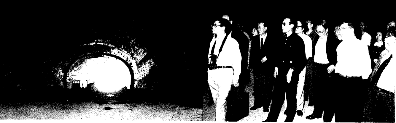
1994年5月17日，地矿部部长宋瑞祥（右二）在辽宁省地矿局坑探队承建的北京西客站鹰山一号隧道工程工地检查工作
