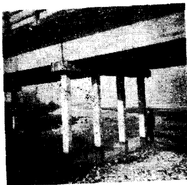
图1.4 单排桩墩（河北）
