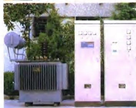
DJ 系列高低压供电装置
