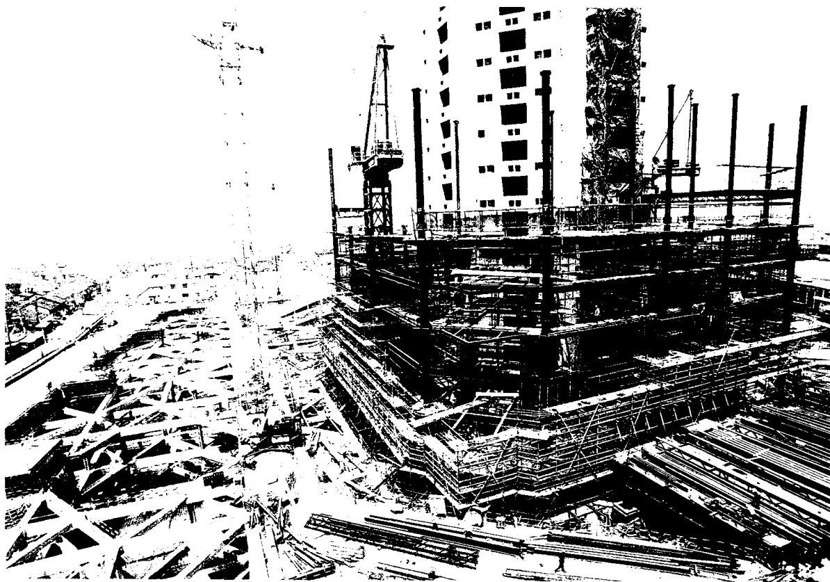
图9 金茂大厦钢结构施工
