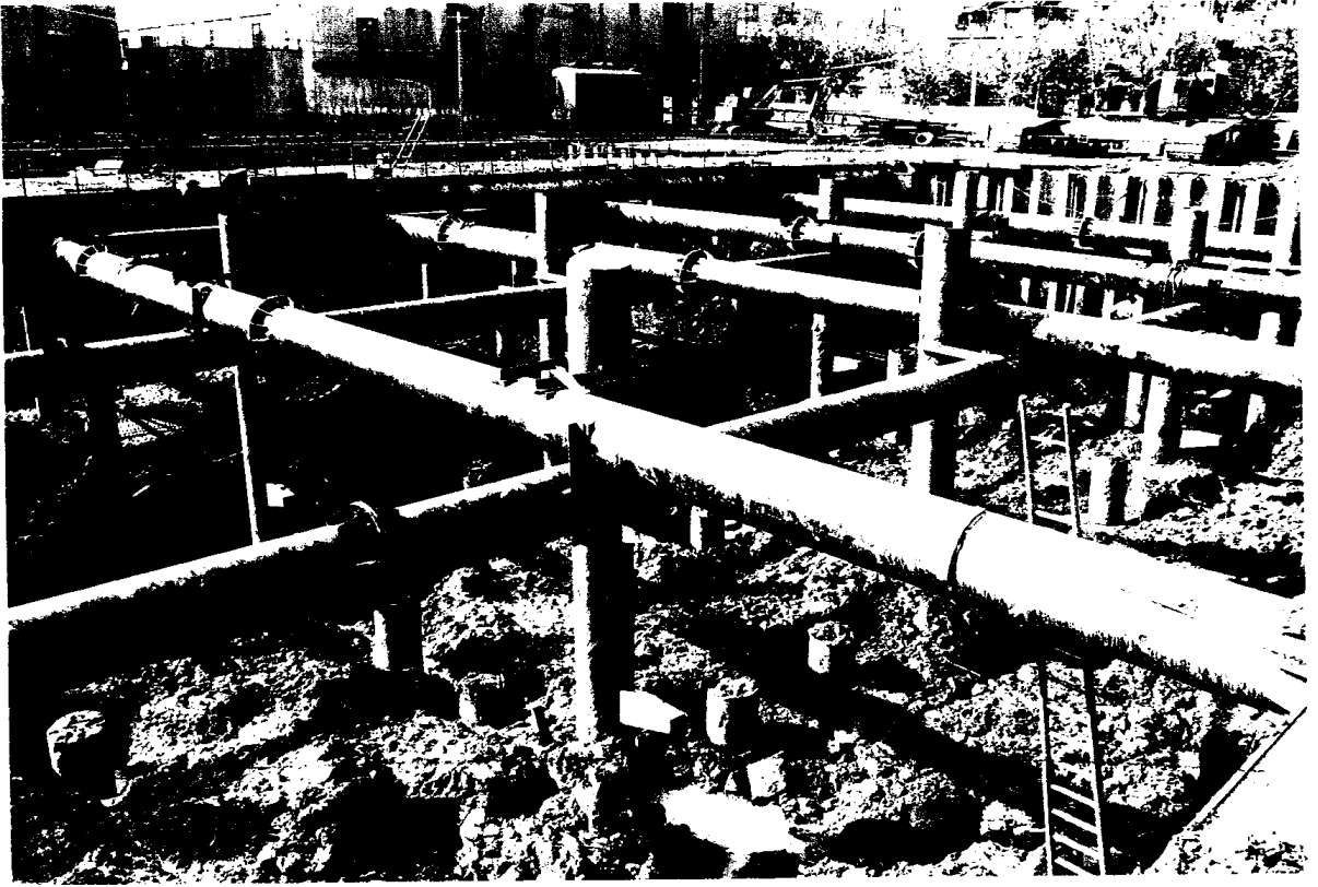
图6 钢板桩、深层搅拌桩与内支撑配套
