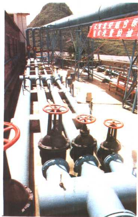
11 水钢水泵直供组合标准表法水流量校验装置
