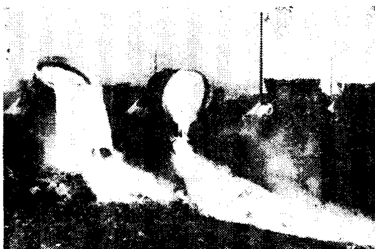
图 1-2 渣罐在浇铸场热泼（英国）
