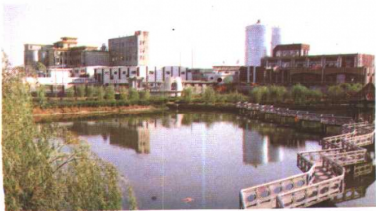
◁ 第二粮油厂厂区全貌
