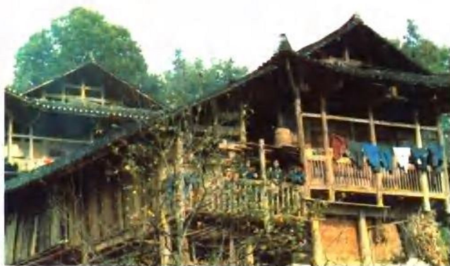
土家族的吊脚楼
