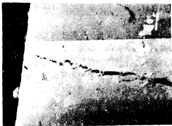
图 9 水泥膨胀剂静态胀裂
