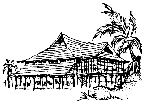
傣族竹楼底层架空，上部轻盈通透，适应潮湿，多雨的气候条件
