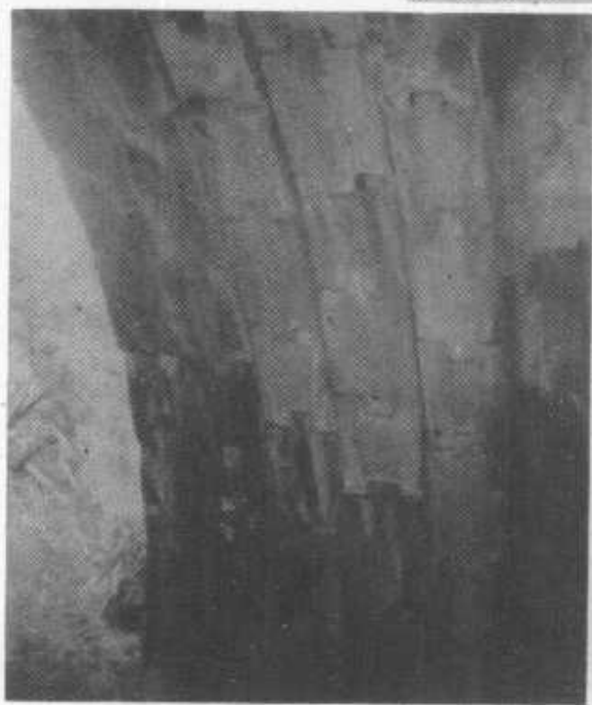
22. 观音桥桥拱 花岗岩石块榫接实况
