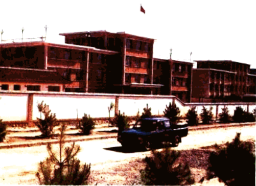
县委、县政府办公大楼
